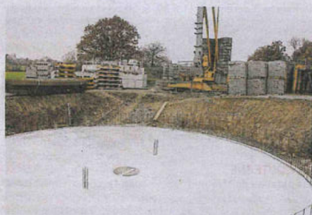
Au 1 er plan, le futur silo à boues.
