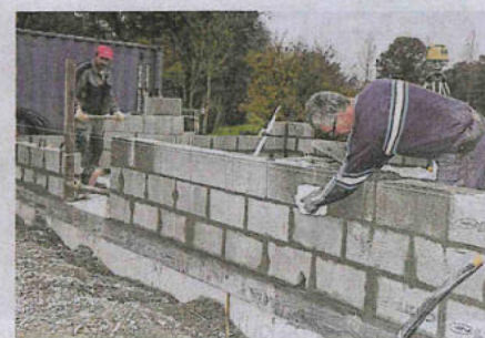
Le local d'exploitation en cours de construction.
