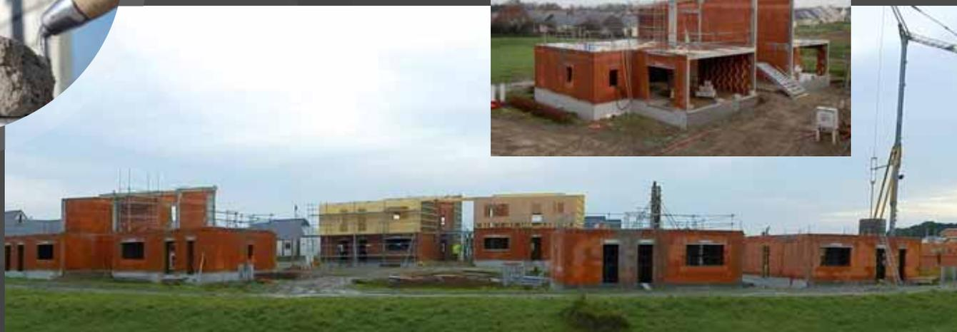
Construction de 16 logements, 4 bâtiments semi-collectifs en maçonnerie brique
